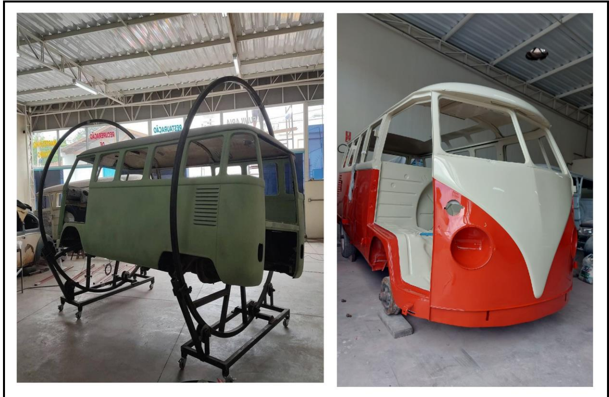
Figura 3. Reparo e pintura.
